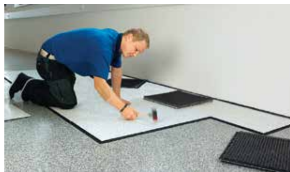
Самостоятельная укладка при помощи молотка с мягкой головкой
